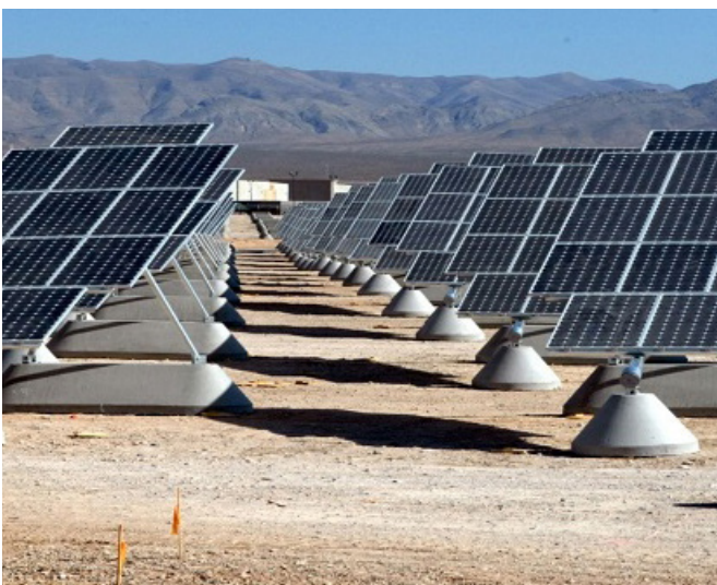
Planta solar Intipampa, ubicada en Pampa Lagunas, región Moquegua.
