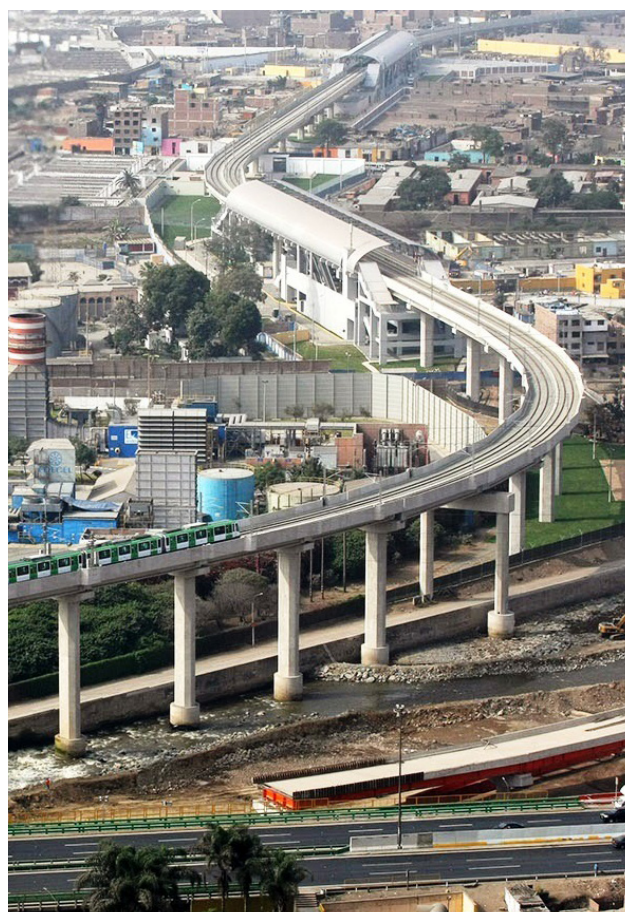
Línea 1 del Metro de Lima.
