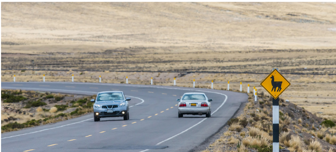
Proyecto del asfaltado de los distritos de Ayaviri, Umachiri, Llalli y Ocuvi en la región Puno.
