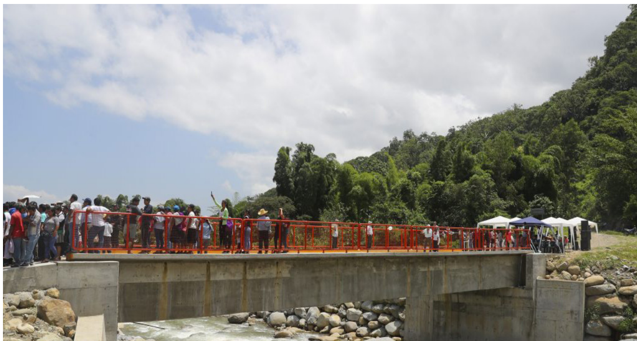
Puente sobre las quebradas de Pusalca y Corrales, Caserío de Huabal en la provincia de Huancabamba.
